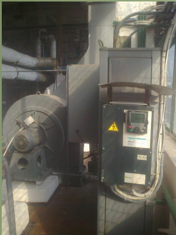
СТАНЦІЯ ЧАСТОТНОГО РЕГУЛЮВАННЯ РОБОТОЮ ВЕНТИЛЯТОРА
