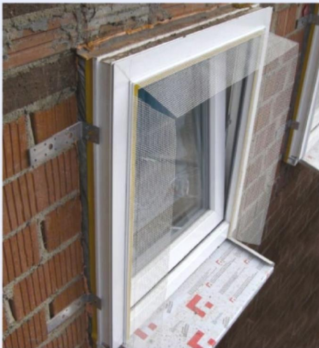
Розміщення вікна перед стіною в ізоляційному шарі
